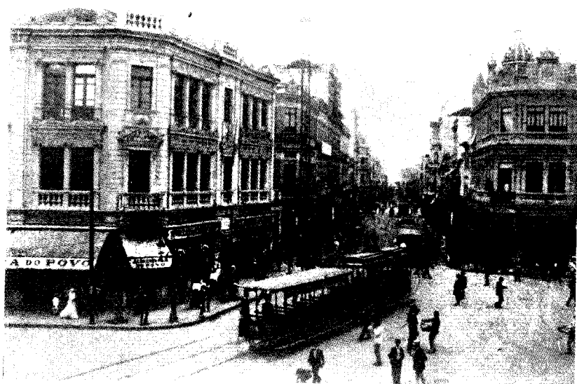
37. Esquina da Rua Uruguaiana, recém-alargada, com o Largo da Carioca, remodelado também, por volta de 1910. Foto Augusto Malta. AGCR]
