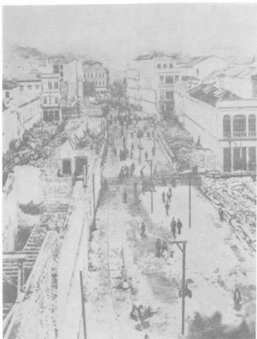
28. As demolições para a abertura da Avenida Central, entre as ruas General Câmara e Santa Luzia
