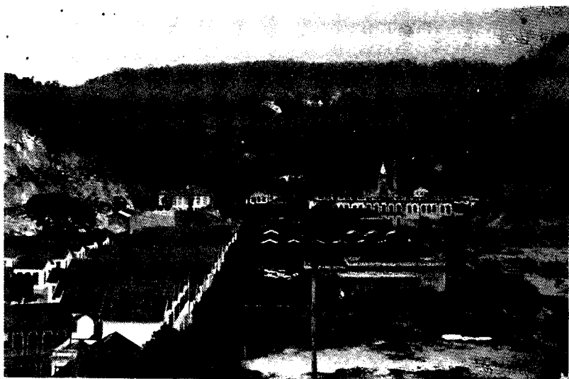
20. Vista geral da fábrica de tecidos Aliança e de sua vila operária, em Iaranjeiras, onde se localiza, hoje, a Rua General Glicério. Foto Augusto Malta. MIS
