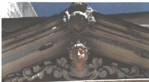
5) Detalhe de ornamento arquitetônico na platibanda de edificação preservada à rua Sacadura Cabral. Foto M.Belandi [2001]
