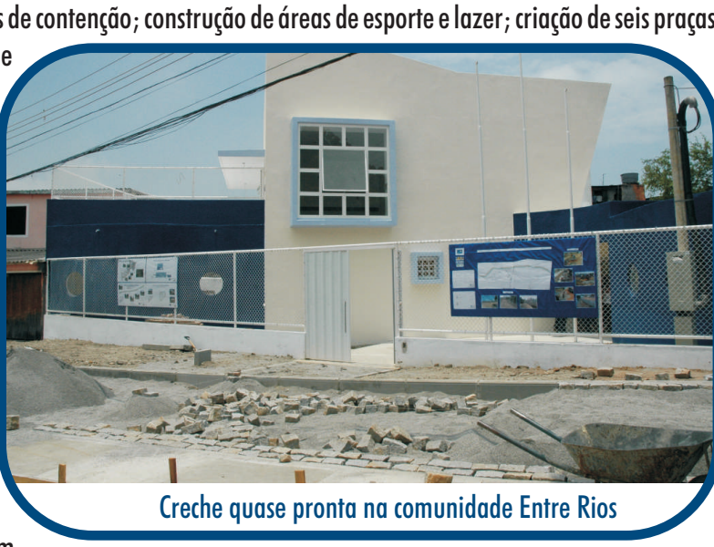
Creche quase pronta na comunidade Entre Rios
