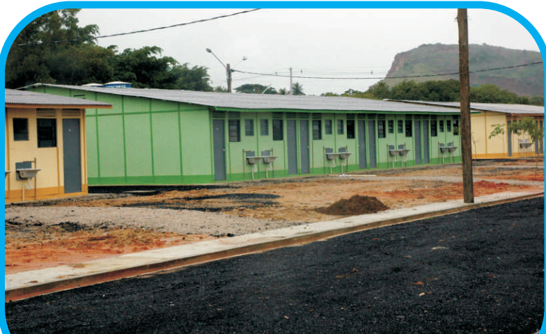
Área dos abrigos tem pavimentação e redes de água e esgoto
