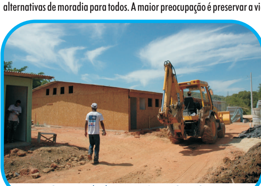
Construção de abrigo provisório em Santa Cruz
