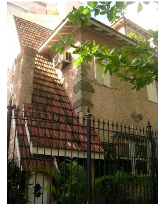
Acentuada inclinação do telhado
