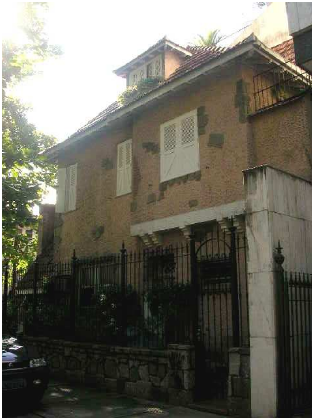
Fachada voltada para a rua Barão da Torre
