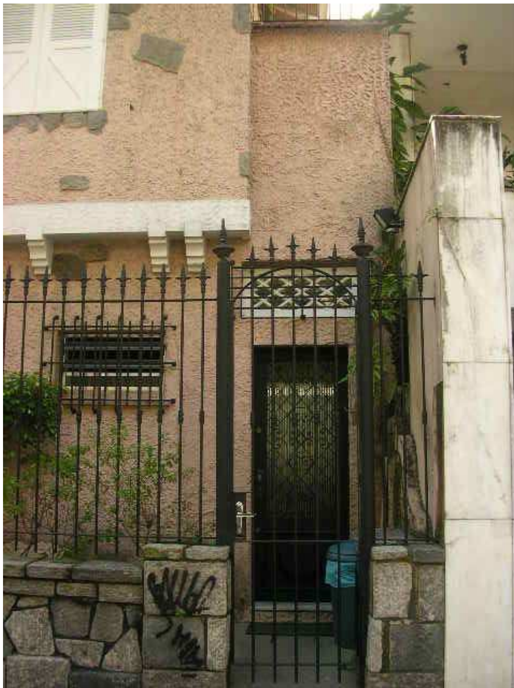
Acesso de serviço na rua Barão da Torre
