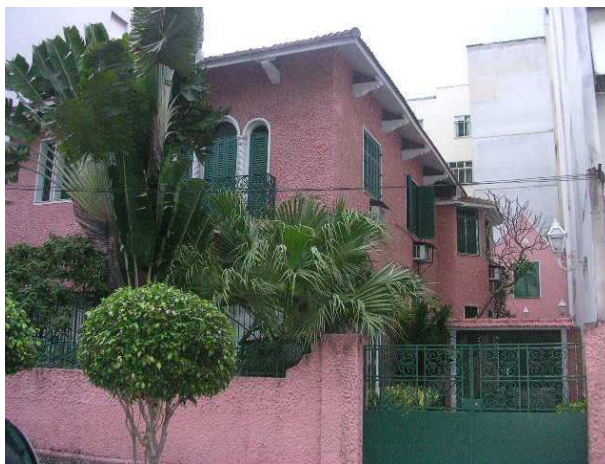
Vista lateral direita do imóvel
