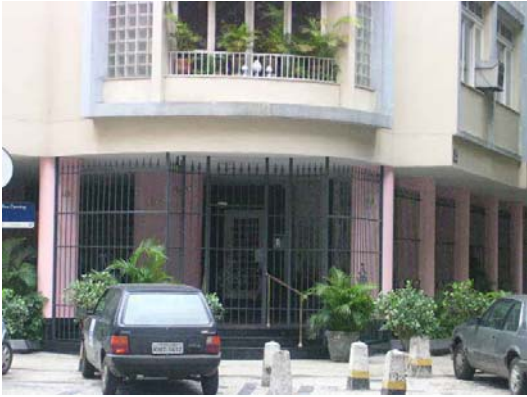
Os pilotis definem vãos livres no pavimento térreo. Detalhe das varandas do corpo cilíndrico, com tijolos de vidro.
