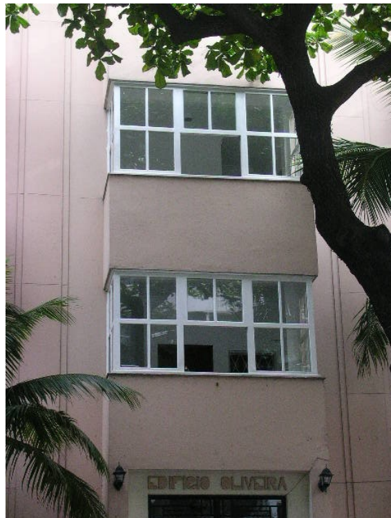
Os vãos de janelas retangulares são guarnecidos de madeira e vidro.
