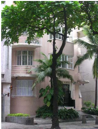
Guarda-corpos com elementos tubulares
