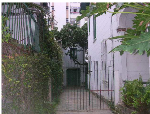
Acesso para carros tendo ao fundo no segundo pavtº um quarto de serviço
