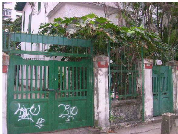
Portão de acesso à garagem
