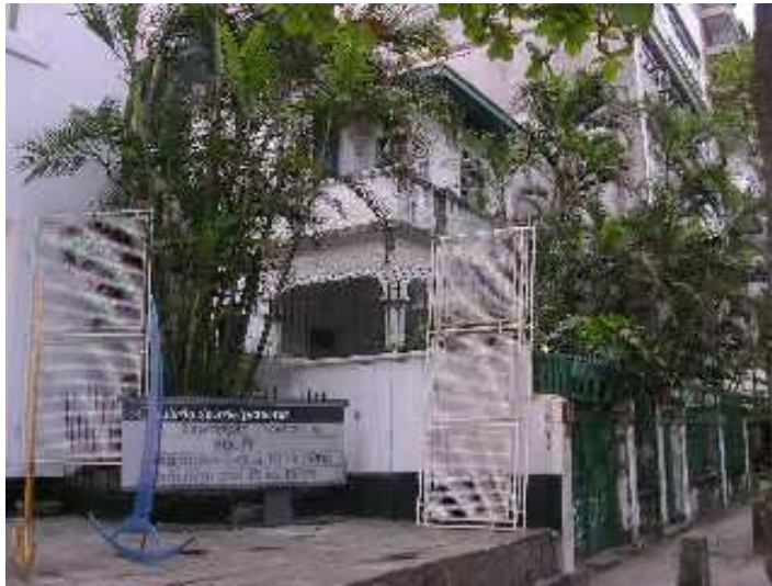
Vista lateral esquerda da edificação
