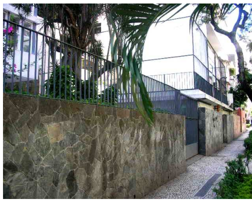
O muro que delimita o prédio do logradouro é executado em pedra.
