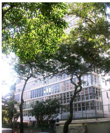
O emprego de panos de vidro na fachada principal confere leveza à fachada
