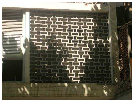
Elementos vazados em uma das tramas da fachada
