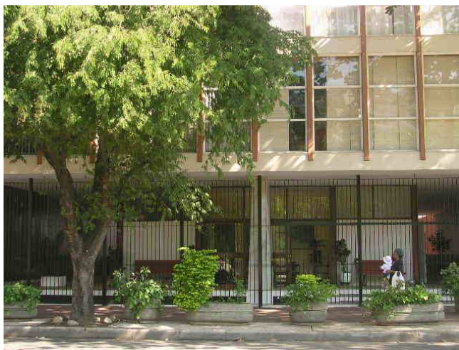
Delimita o prédio do logradouro uma grade de barras verticais executada em ferro
