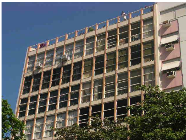
A fachada é definida por vãos modulados vedados por vidro
