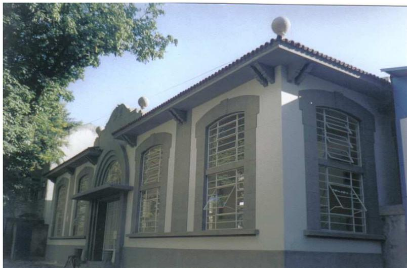
Um beiral se desenvolve ao longo de toda a construção, sendo revestido em madeira, estando também presentes mãos francesas dispostas segundo intervalos regulares. Do logradouro podem ser vistas telhas do tipo colonial.
