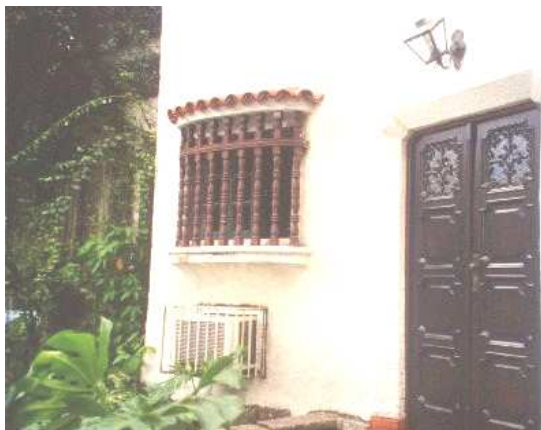
Fig. 06 – Balaústres de madeira torneada.
