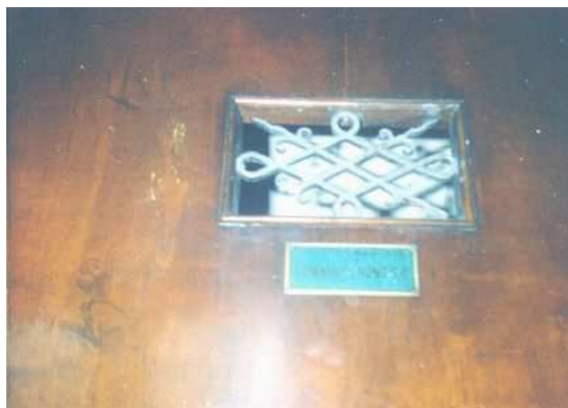
Fig. 26 – Detalhe da porta do elevador.
