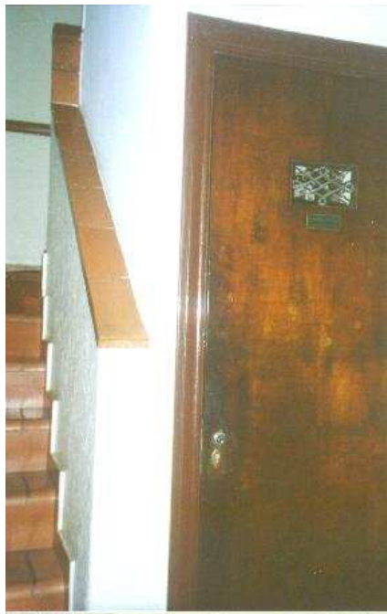
Fig. 25 – Porta do elevador inglês.
