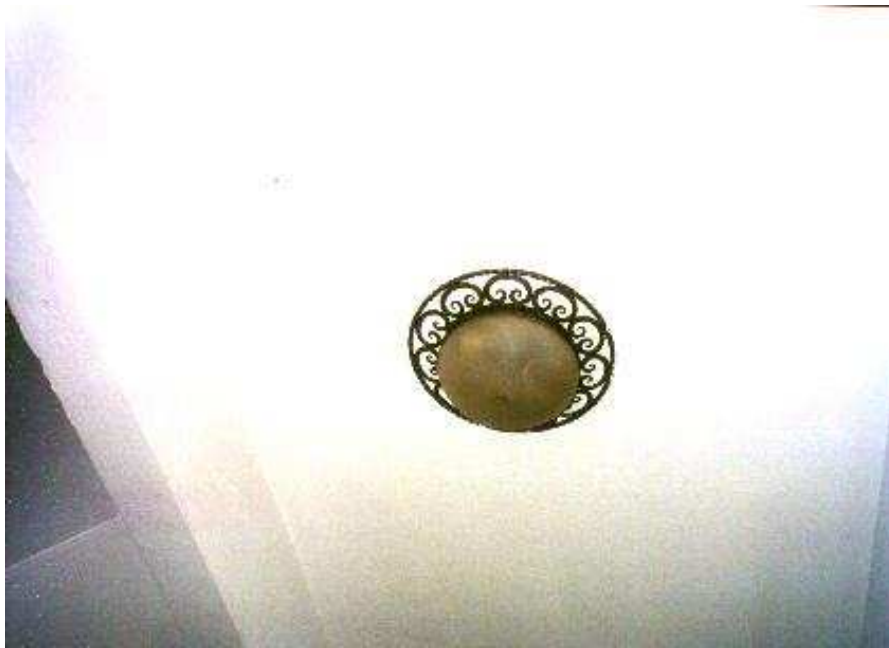
Fig. 30 – Luminária original do hall de acesso aos apartamentos.
