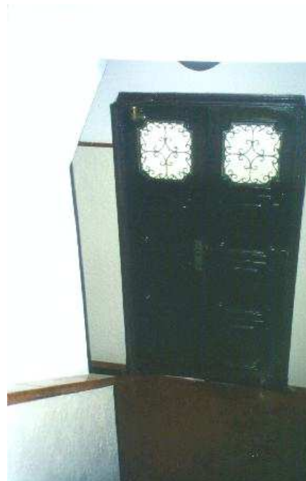
Fig. 24 – Lado interno da porta principal.
