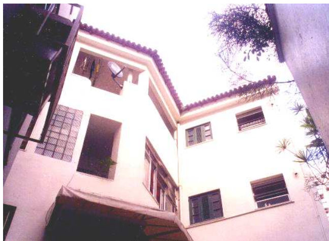
Fig.21 – Vãos e esquadrias diferentes da construção original.
