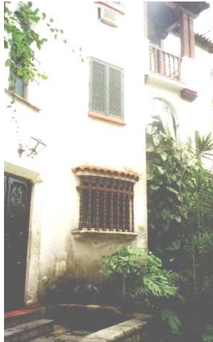
Fig. 08 – Vãos com madeira e vidro e folhas com venezianas.
