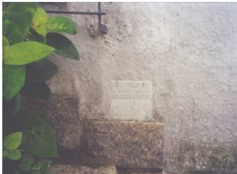
Fig. 16 – Placa da empresa construtora.
