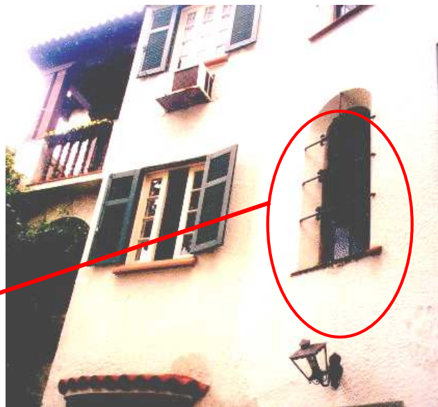
Fig. 10 – Trabalho de ferro forjado que protege as áreas envidraçadas
