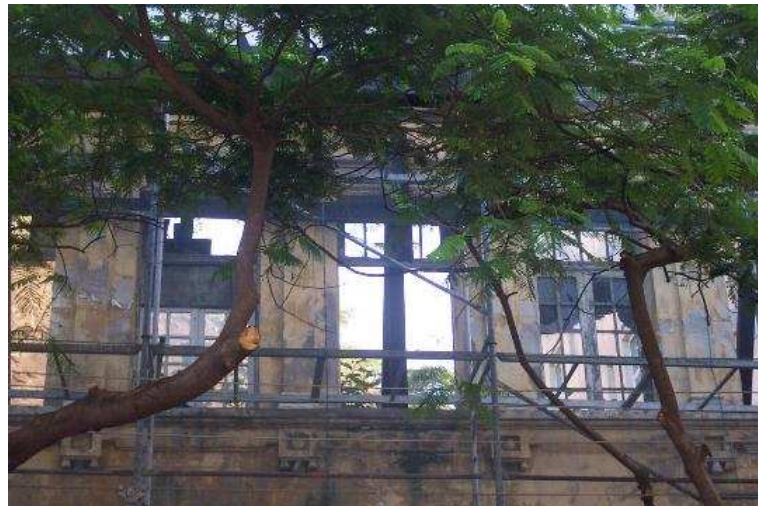
Figura 12 – Esquadrias ausentes ou quebradas, no 2º pavimento.
