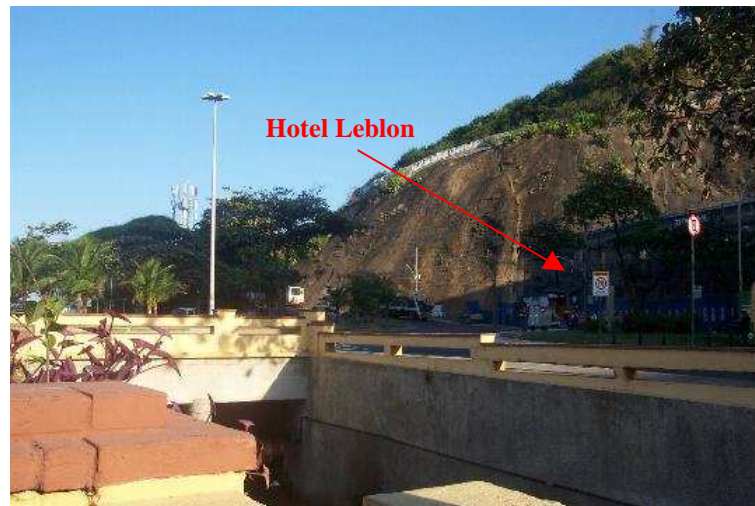
Figura 2 – Hotel Leblon visto do canal da avenida Visconde de Albuquerque, à esquerda a subida da avenida Niemeyer.
