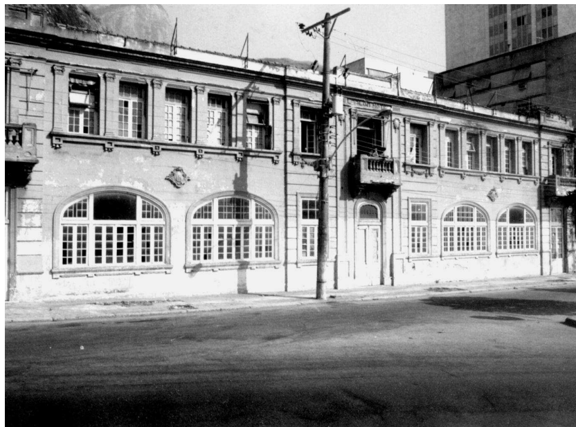
Figura 13 – Fachada do antigo Hotel Leblon.
