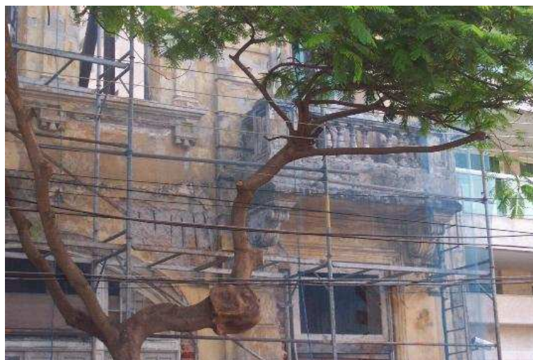
Figura 21 – Balcão da lateral esquerda do 2º pavimento.
