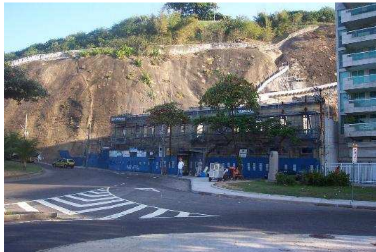
Figura 14 – Fachada do antigo Hotel Leblon.
