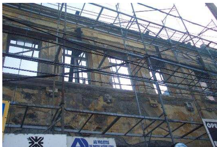
Figura 18 – Vãos de verga reta do 2º pavimento.
