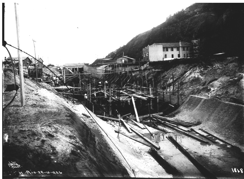
Figura 14 – Construção do canal da av. Visconde de Albuquerque. 8
