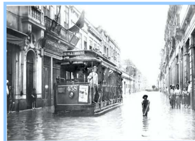
Rua inundada do Flamengo
